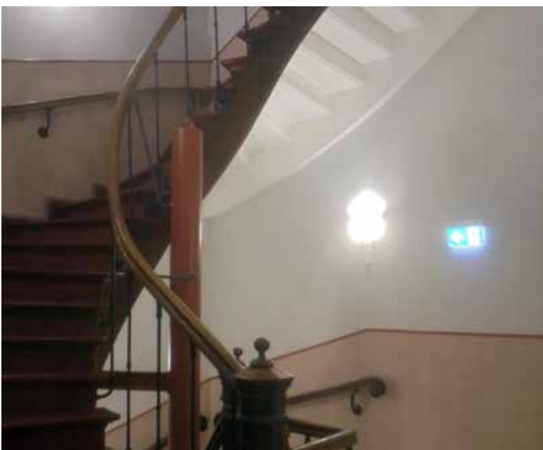
Man kann wieder hochgehen: im Treppenhaus zum Wagnerzimmer.
